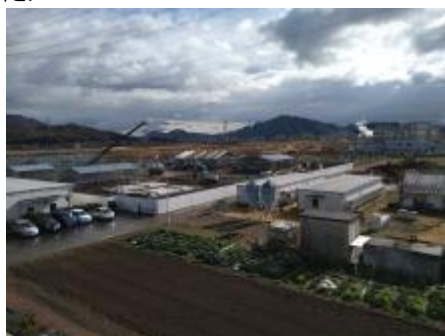
図-1 産業動物舎改築の様子
